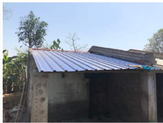
After)ワーク後の屋根の様子
