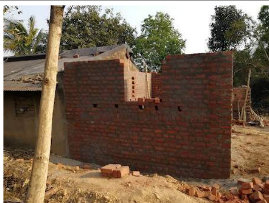
After)窓の様子
