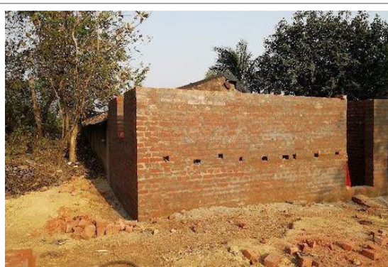
After)壁の様子
