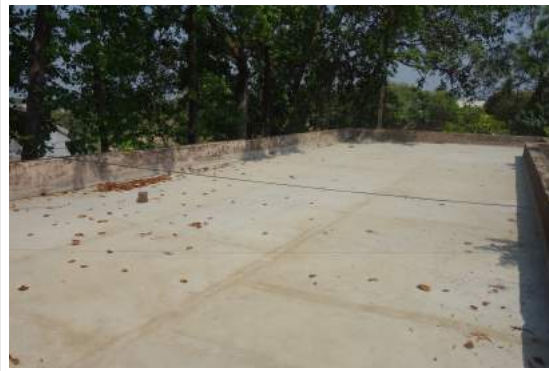
After) ワーク後の屋上の様子
