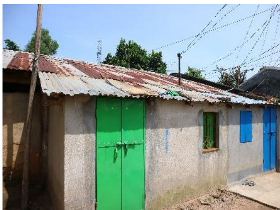
図 1 修繕前の屋根
