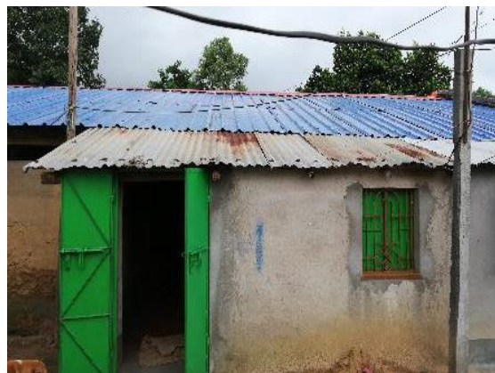
図 2 修繕後の屋根
