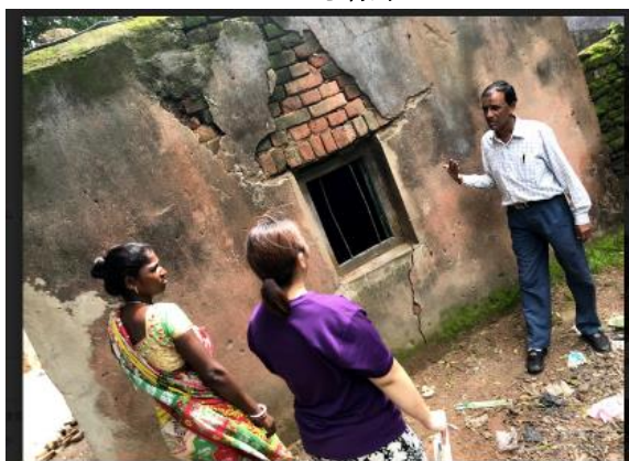
図 4 家屋の状態を確認している様子
