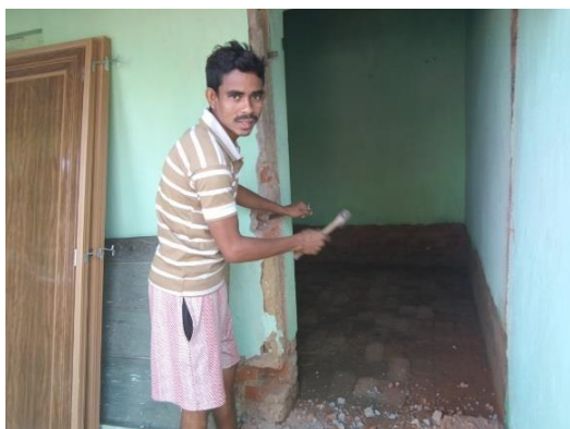
(栽培小屋の扉の修理、交換)
