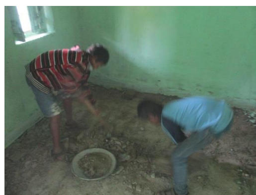
(栽培小屋の床の修復)
