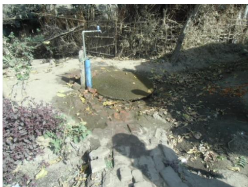
(整備前の水道周り)
