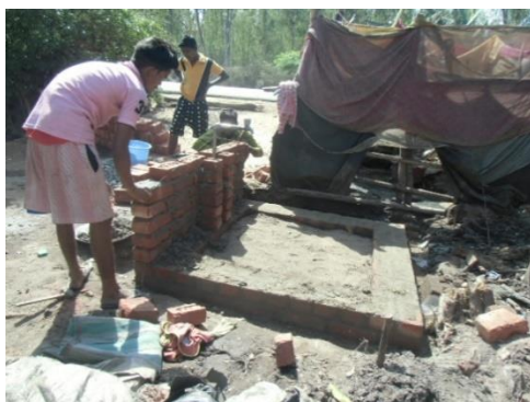
(水道のパイプ周りをレンガで補強)
