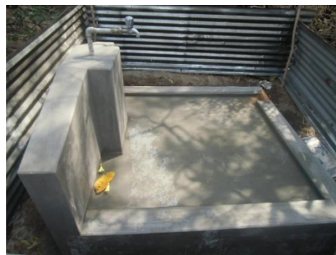
(整備後の水道)
