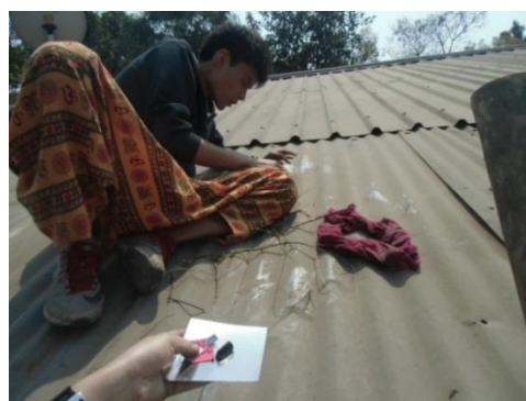
(実際に修復を行っているところ)
