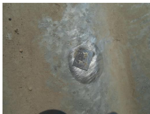
(ステンレス板を用いて修理)
